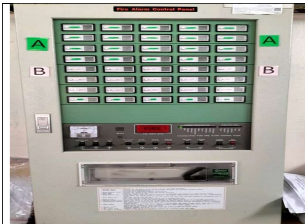
รูปที่ 2.4.6-8 แผงควบคุม (FCP)
