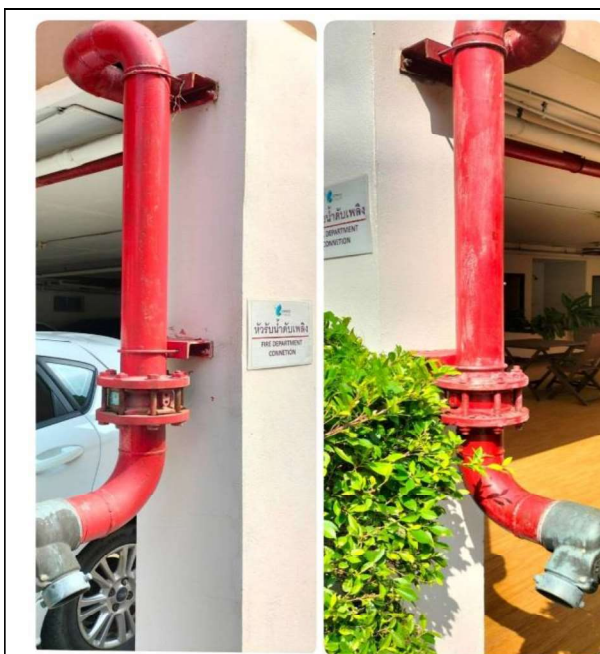
รูปที่ 2.4.6-3 หัวรับน้ำดับเพลิงภายนอกอาคาร
